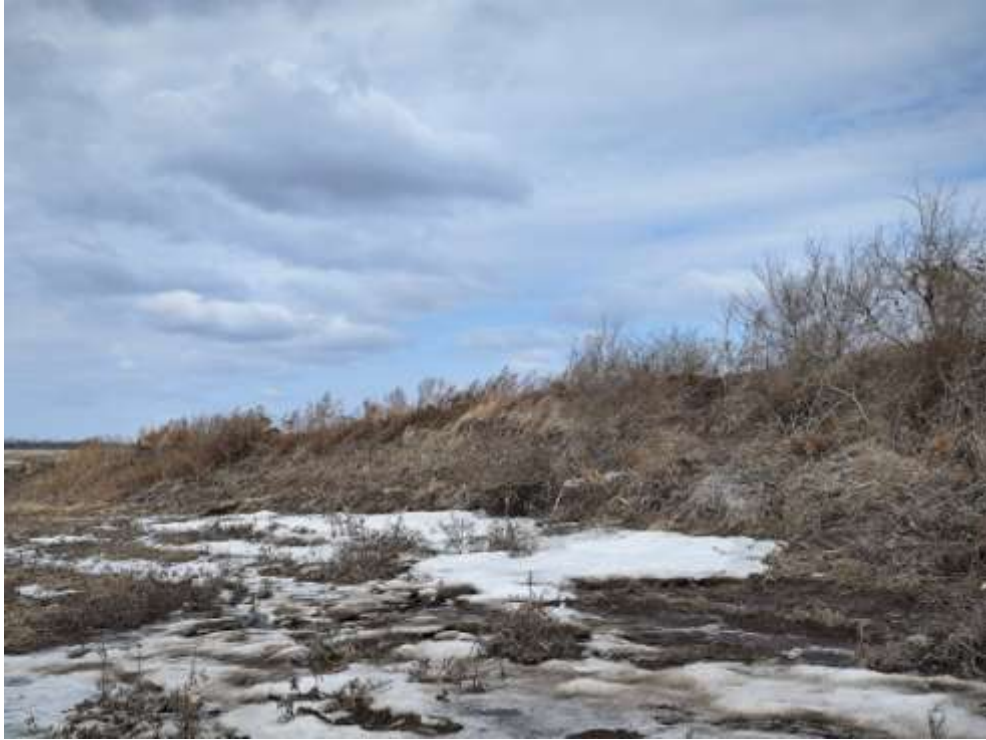
图3-4-2项目区北侧边坡坡面植被发育，坡体稳定
