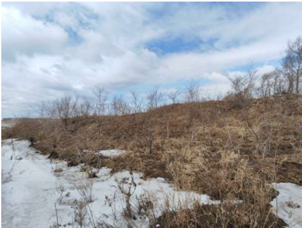
图3-4-3项目区南侧边坡坡面植被发育，坡体稳定
